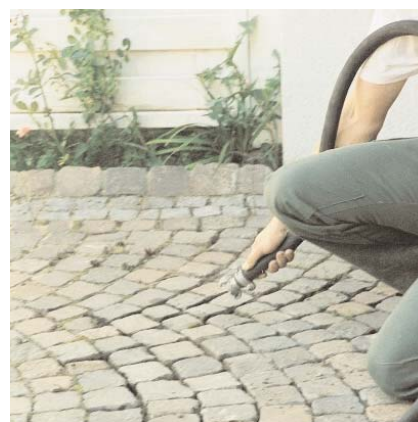
Fugerne rengøres grundigt, inden PCI Pavifix 1K påføres.
