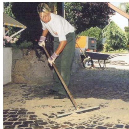
PCI Pavifix 1K fordeles og fejes ned i fugerne.
